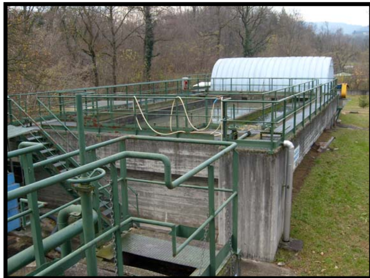
6 Vasca Imhoff e Biodischi
