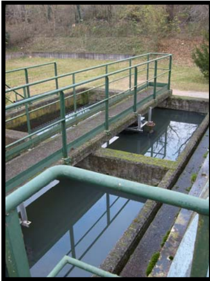
9 sedimentazione secondaria
