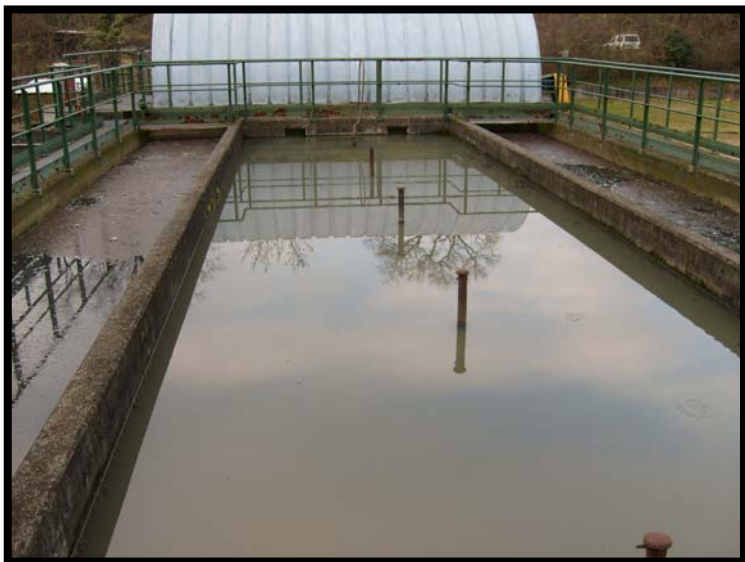
7 Vasca Imhoff e Biodischi
